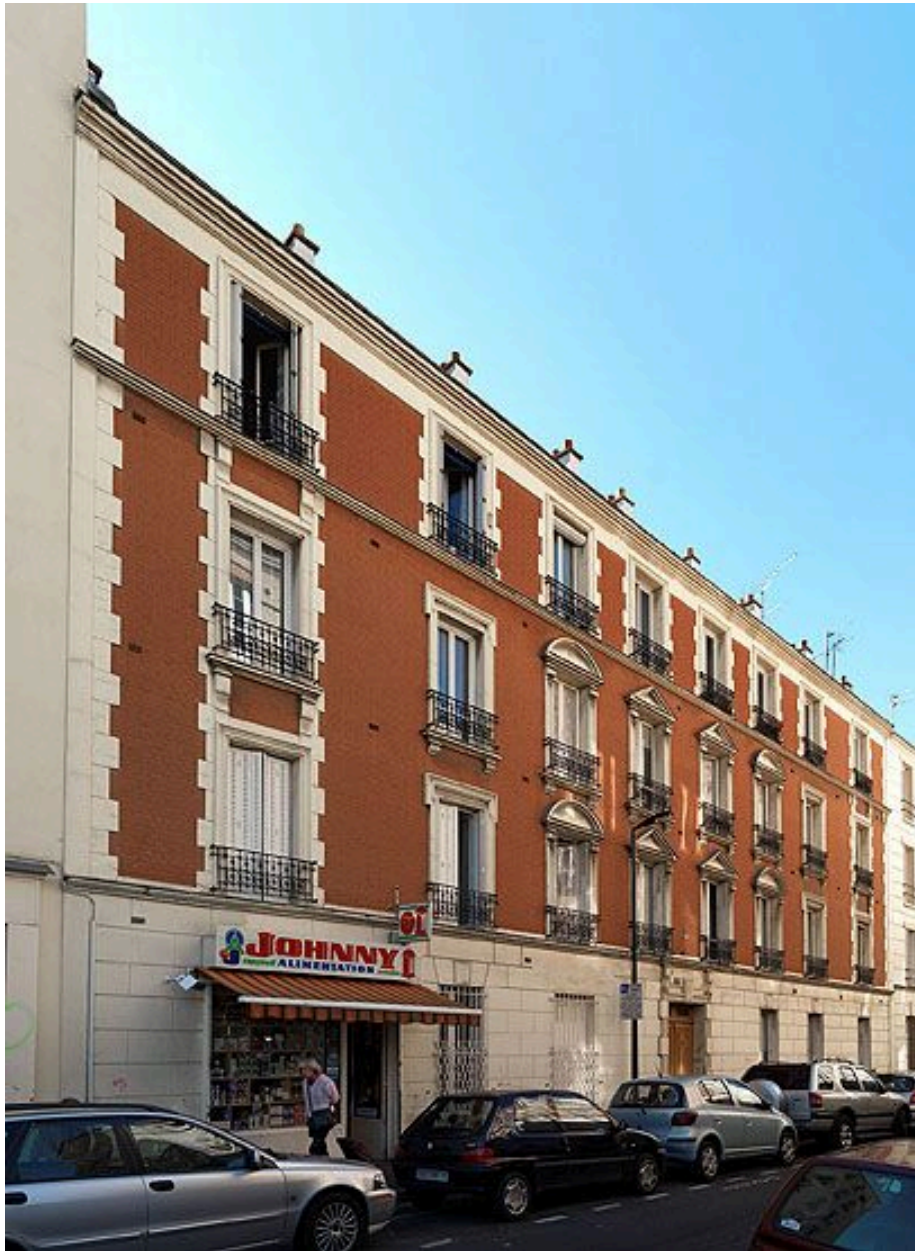
92, Malakoff, immeuble , 11 rue Raymond-Fassin . Elévation de la façade de brique sur la rue.
