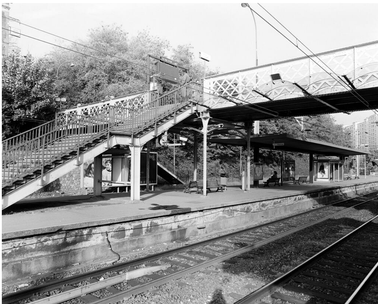
Gare du Val d'Or, passerelle en charpente métallique
