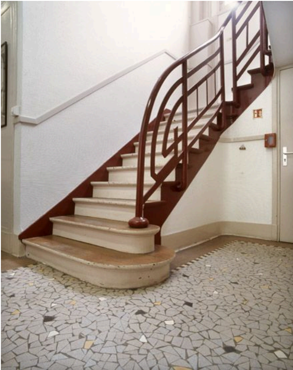
Collège Henri Cahn, 26 boulevard Galliéni. Détail d'un départ d'escalier intérieur. Le sol en ""carrelage cassé"" est d'origine.
