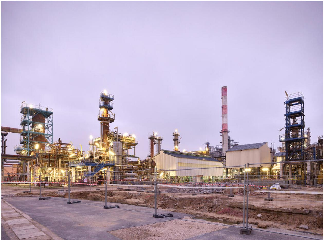
Unités Ouest. Vue prise au coeur des Unités Ouest. Au fond, les anciennes Unités de fabrication de gasoil routier, prochainement converties en unité de fabrication de biocarburant aérien (projet Biojet). Au premier plan, chantier de constructions neuves pour le projet Biojet.
