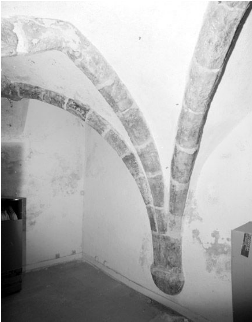
La cave médiévale : vue du corbeau accueillant la retombée des ogives, au milieu du mur sud.
