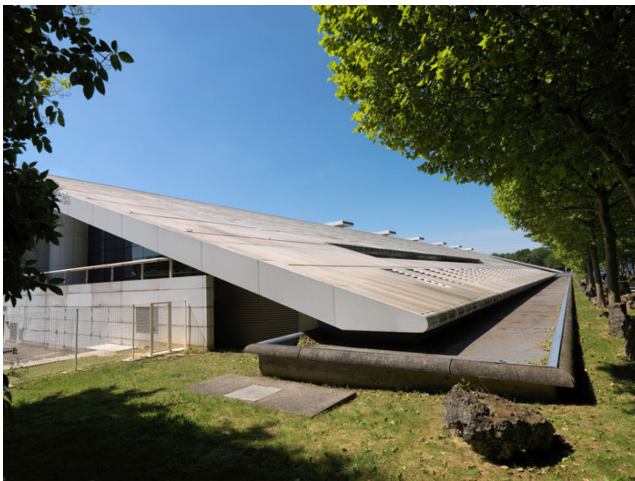
Vue de l'angle sud-est du bâtiment.
