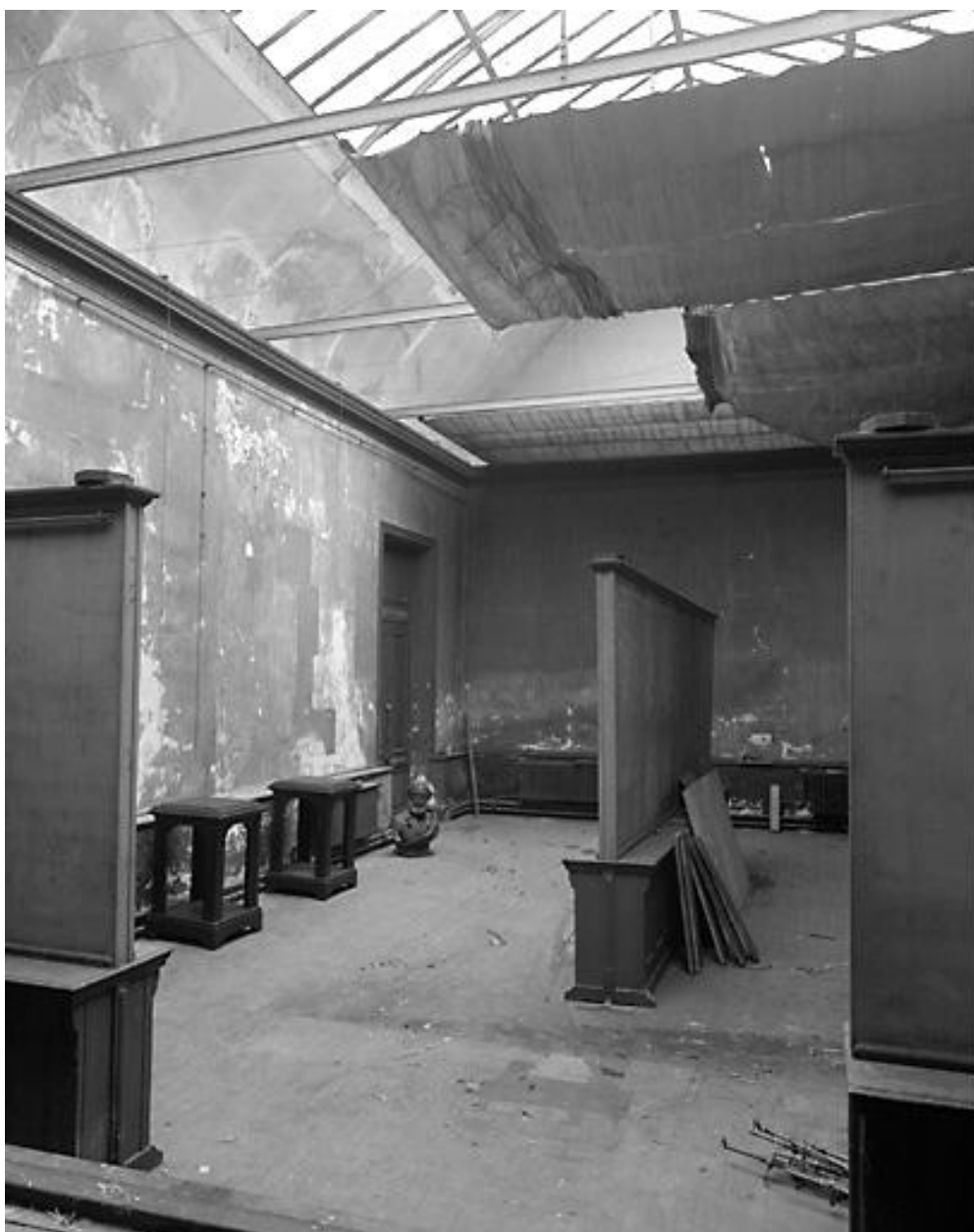
Vue intérieure du pavillon du "musée" avant restauration.
