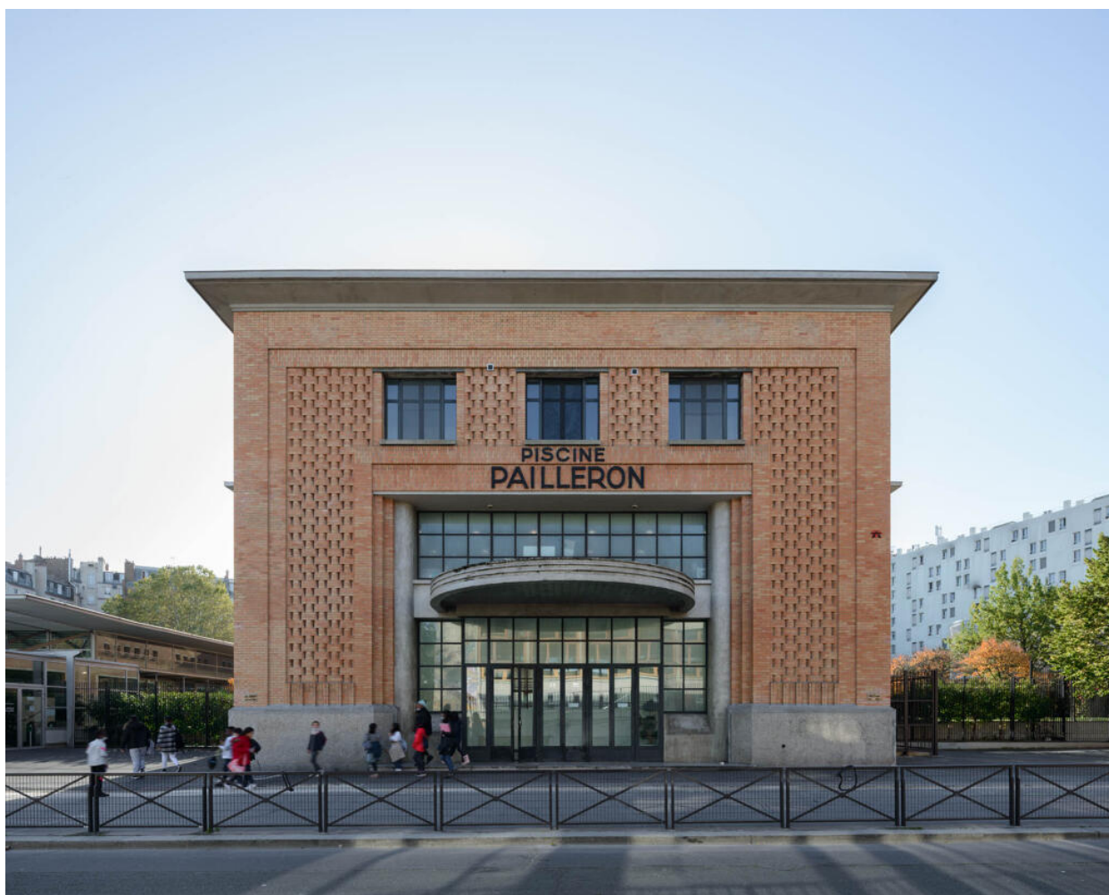
Piscine Pailleron. Façade principale.
