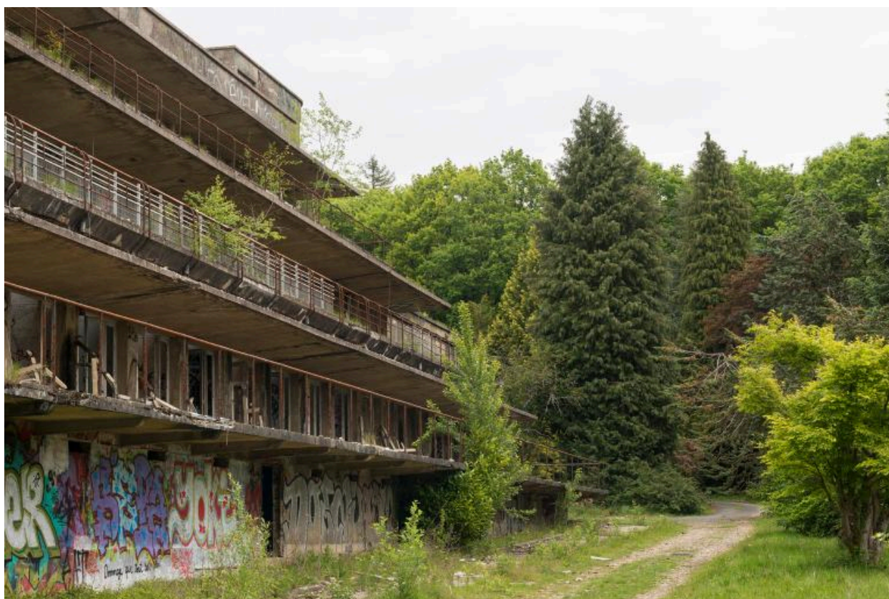
pavillon Bonnefoy-Sibour, façade sud (3)
