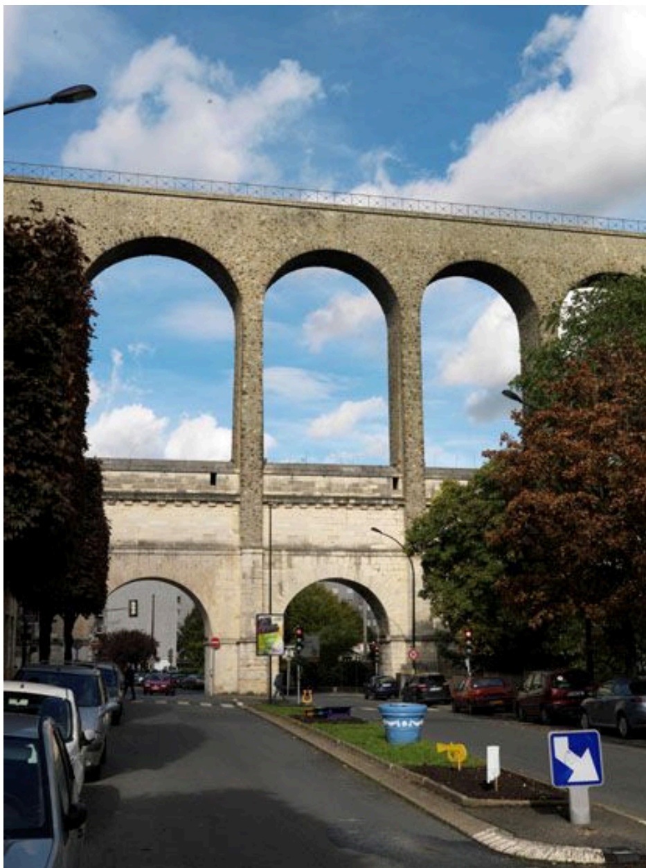
Arcueil. Vue sur les arcades du pont-aqueduc du Médicis à Arcueil.
