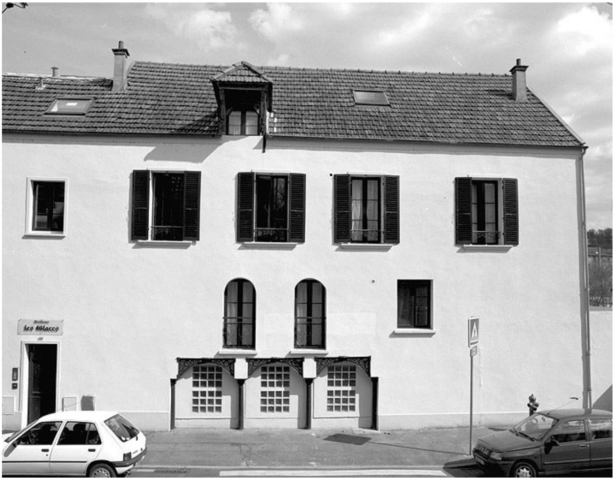
Vue de la façade.
