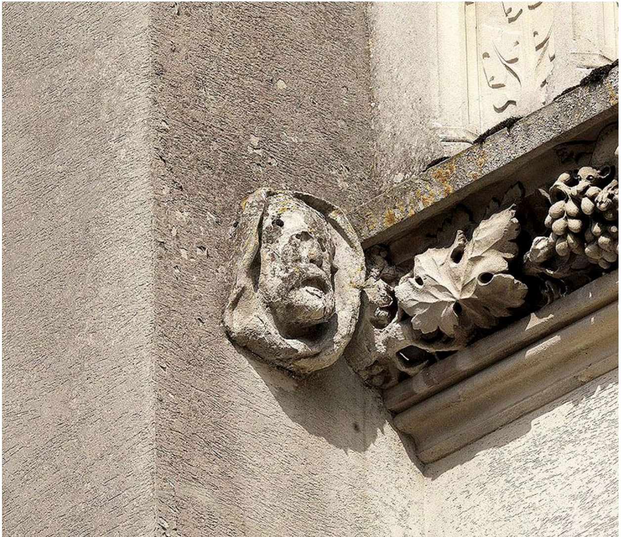
Le pignon ouest de la chapelle : détail d'un portrait sculpté sur le contrefort gauche.
