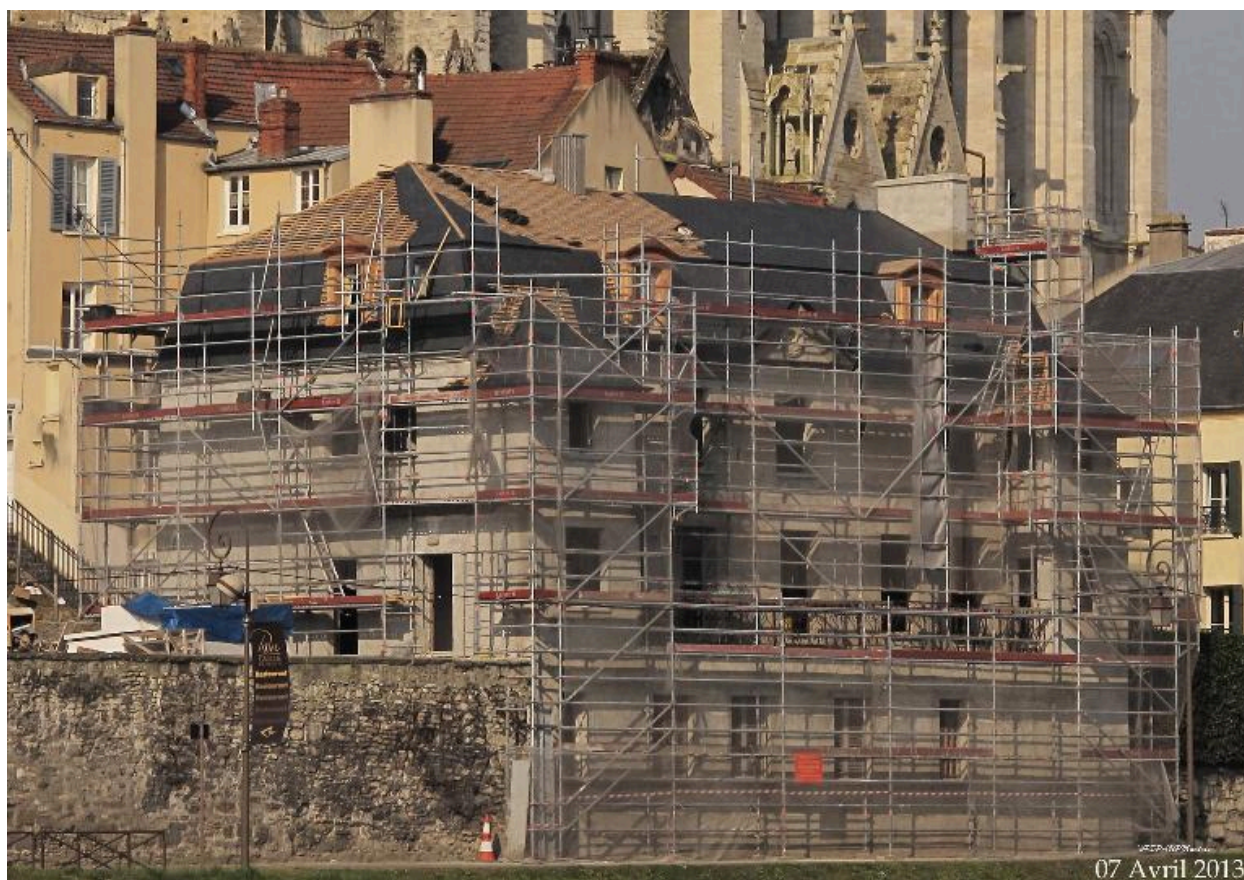
La façade sur Seine en cours de restauration : étape d'avril 2013.
