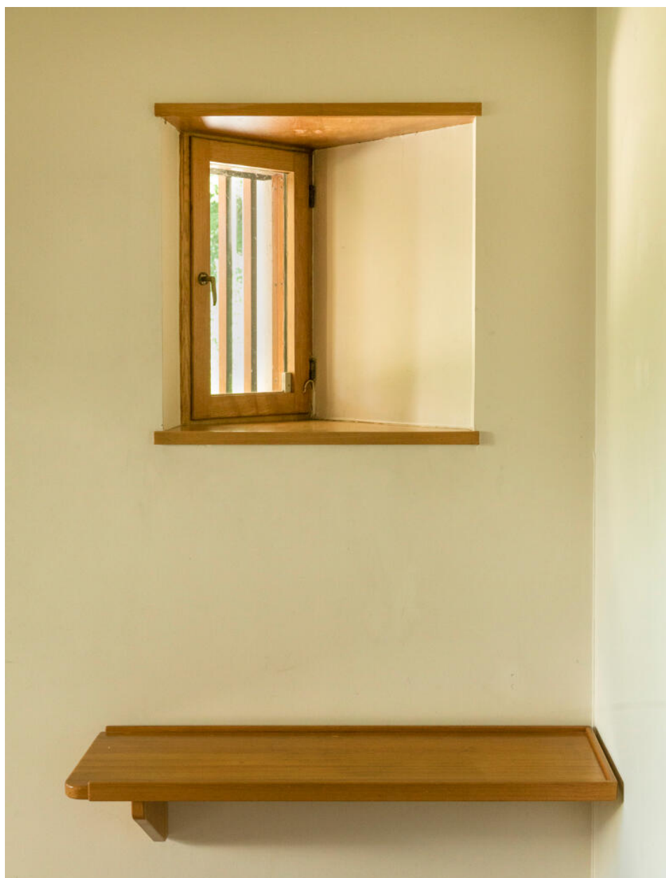
Détail du fenestron en biais ouvrant sur la façade d'entrée.
