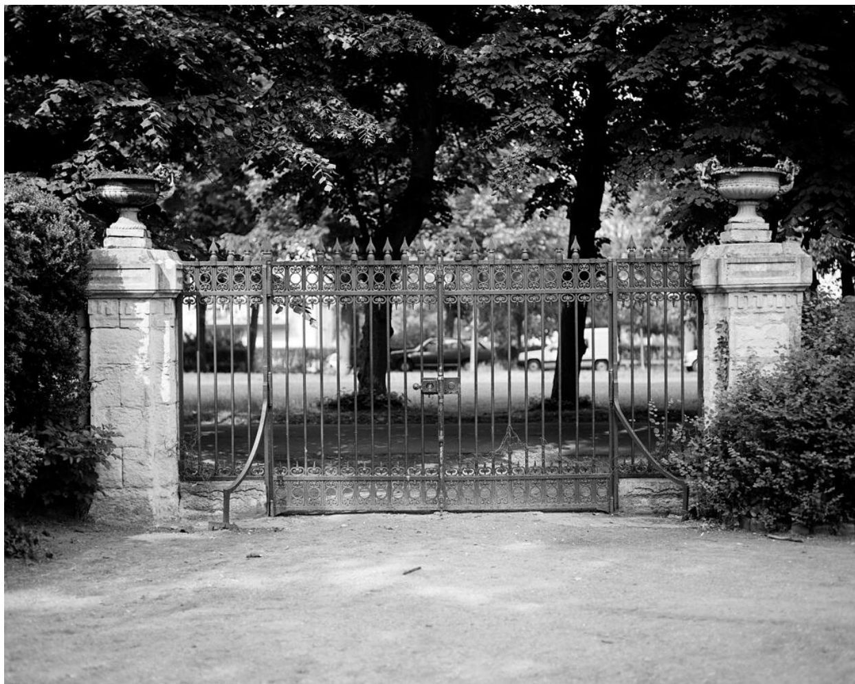
Vue d'ensemble du portail, prise depuis l'intérieur du parc.
