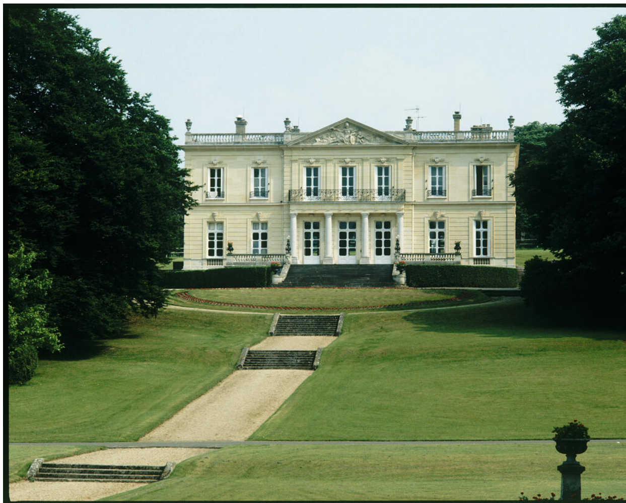
Face postérieure sur le parc.
