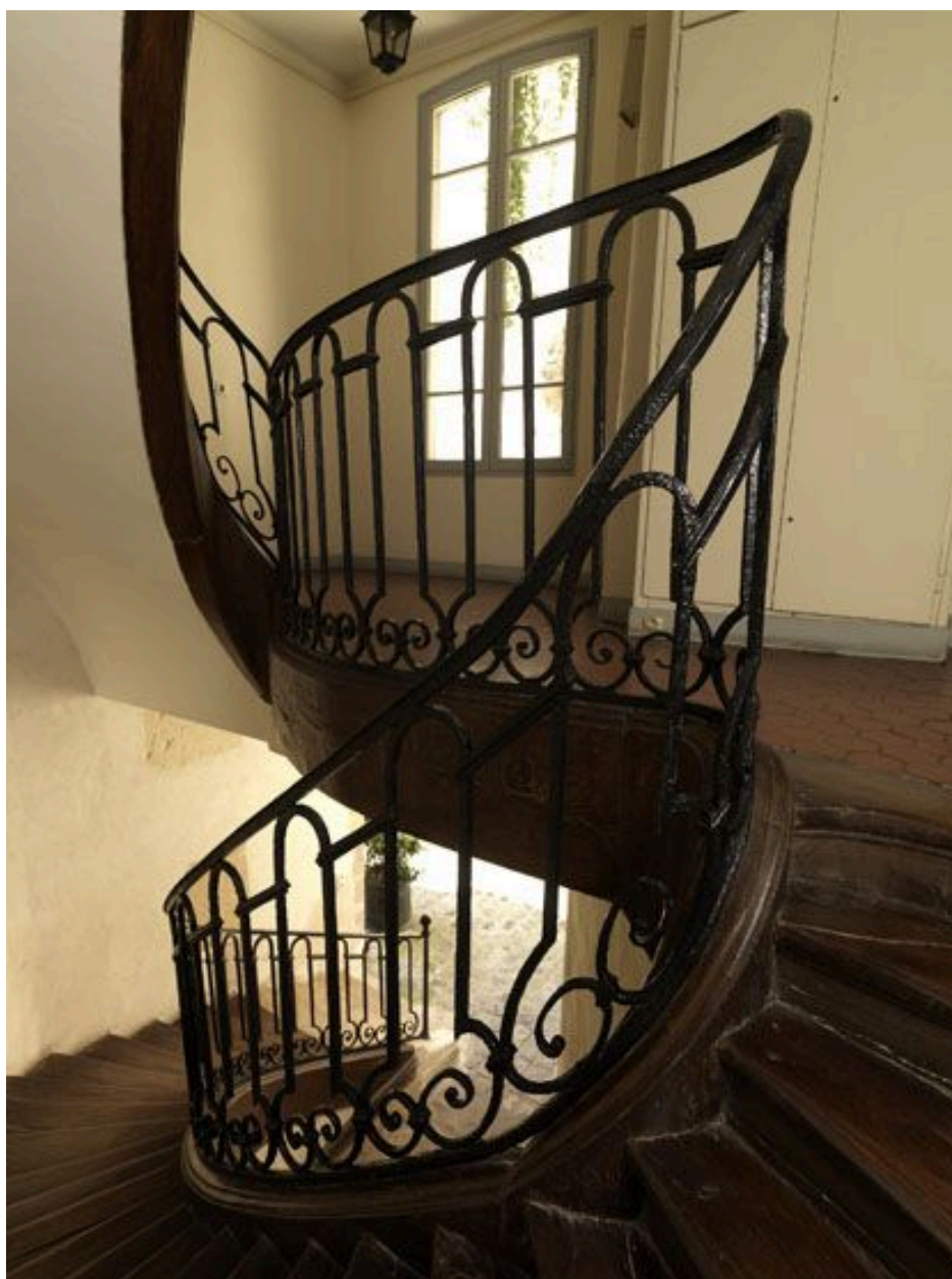
La première volée et le premier palier.
