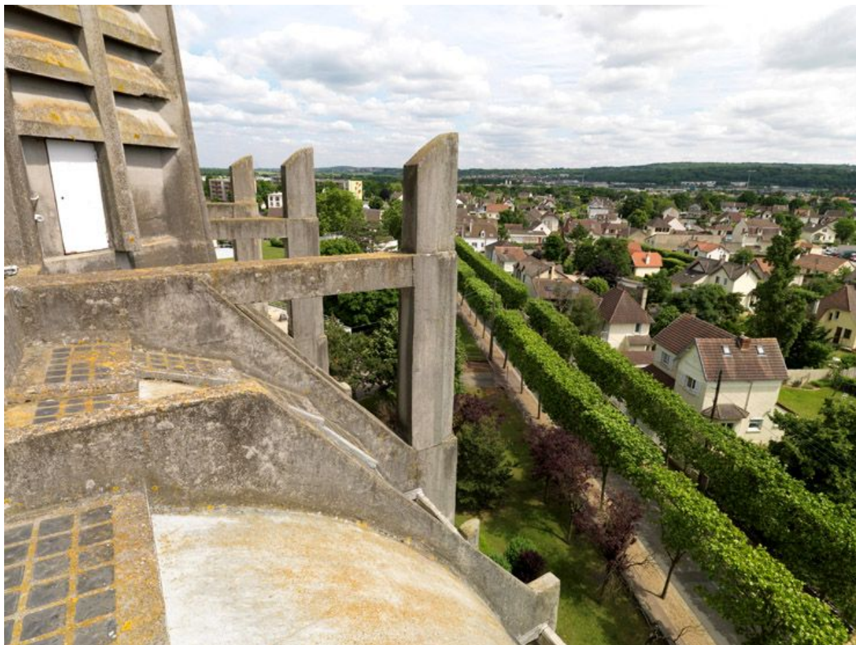
Système de contrebuttement de l'église.
