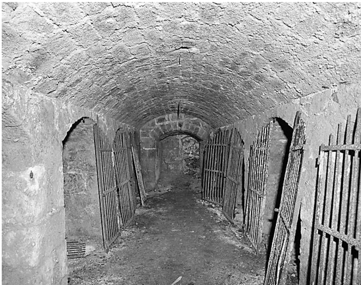
Deuxième niveau de cave : vue depuis l'entrée.
