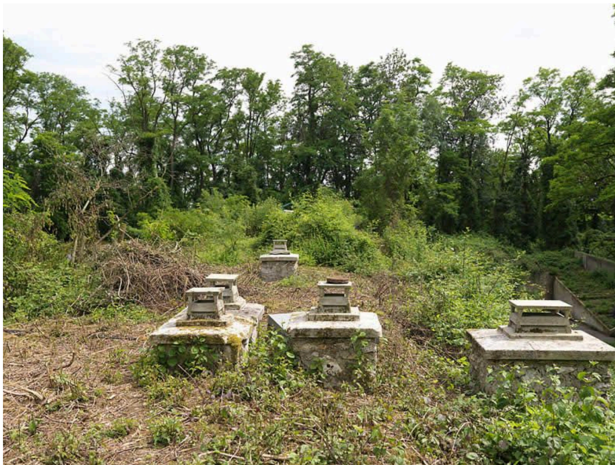
Vue de la partie supérieure de la batterie sud (bouches d'aération des casemates).
