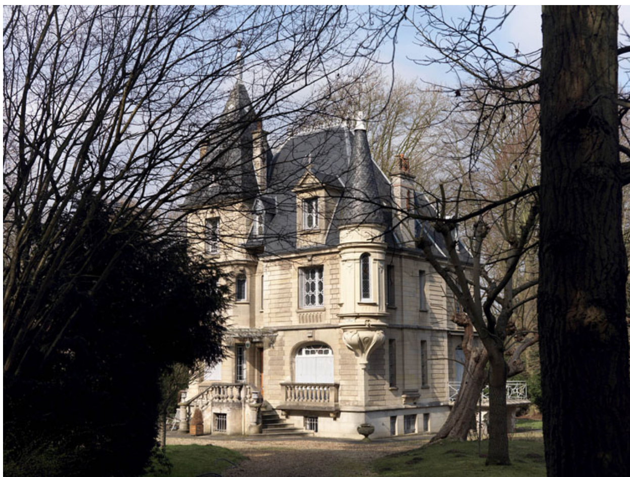
Vue générale, depuis l'entrée de la propriété.
