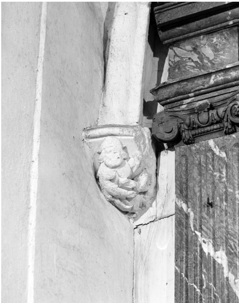
Culot arrière gauche de la deuxième travée (mutilé lors de la pose du retable). Etat en 1991.
