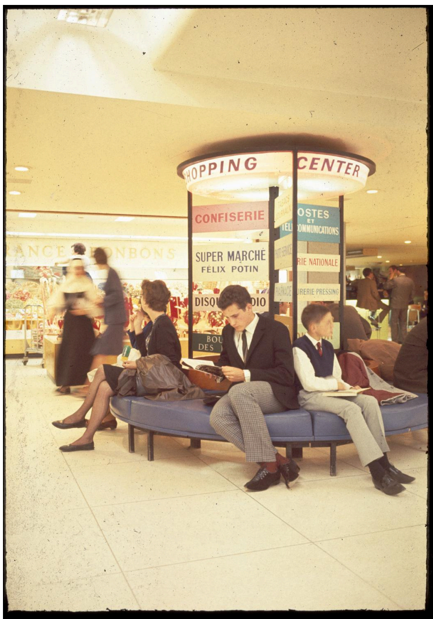
1961, le centre commercial, 1er sous-sol.
