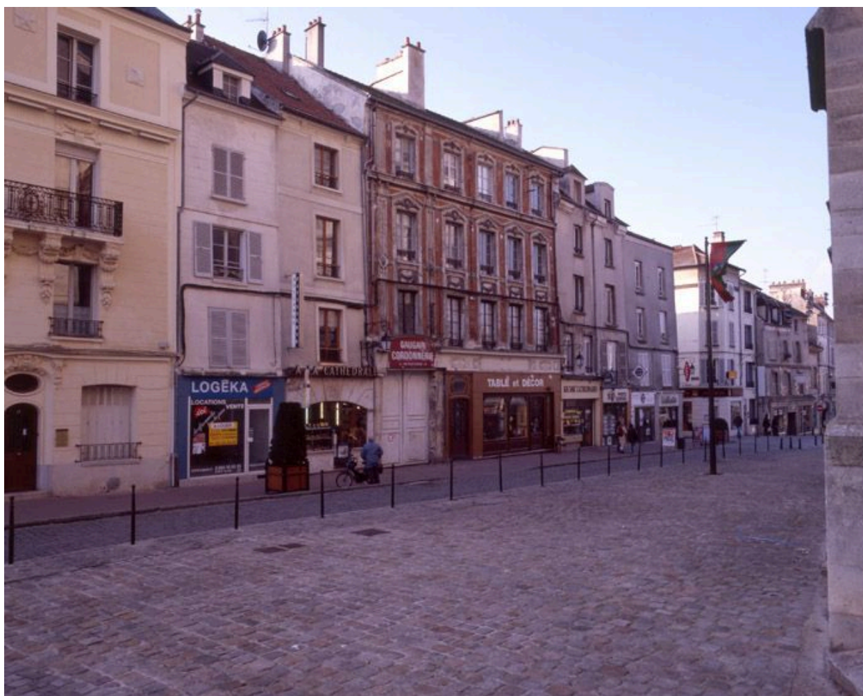
Façade donnant sur le parvis sud de la cathédrale. L'ancien relais de poste se trouve au centre de la photo.
