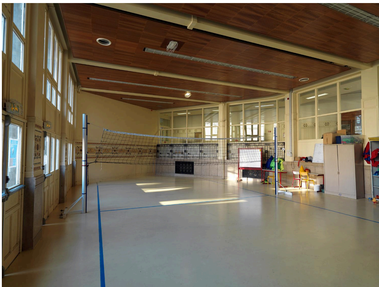
Vue générale d'un préau couvert, aujourd'hui transformé en salle de gymnastique.
