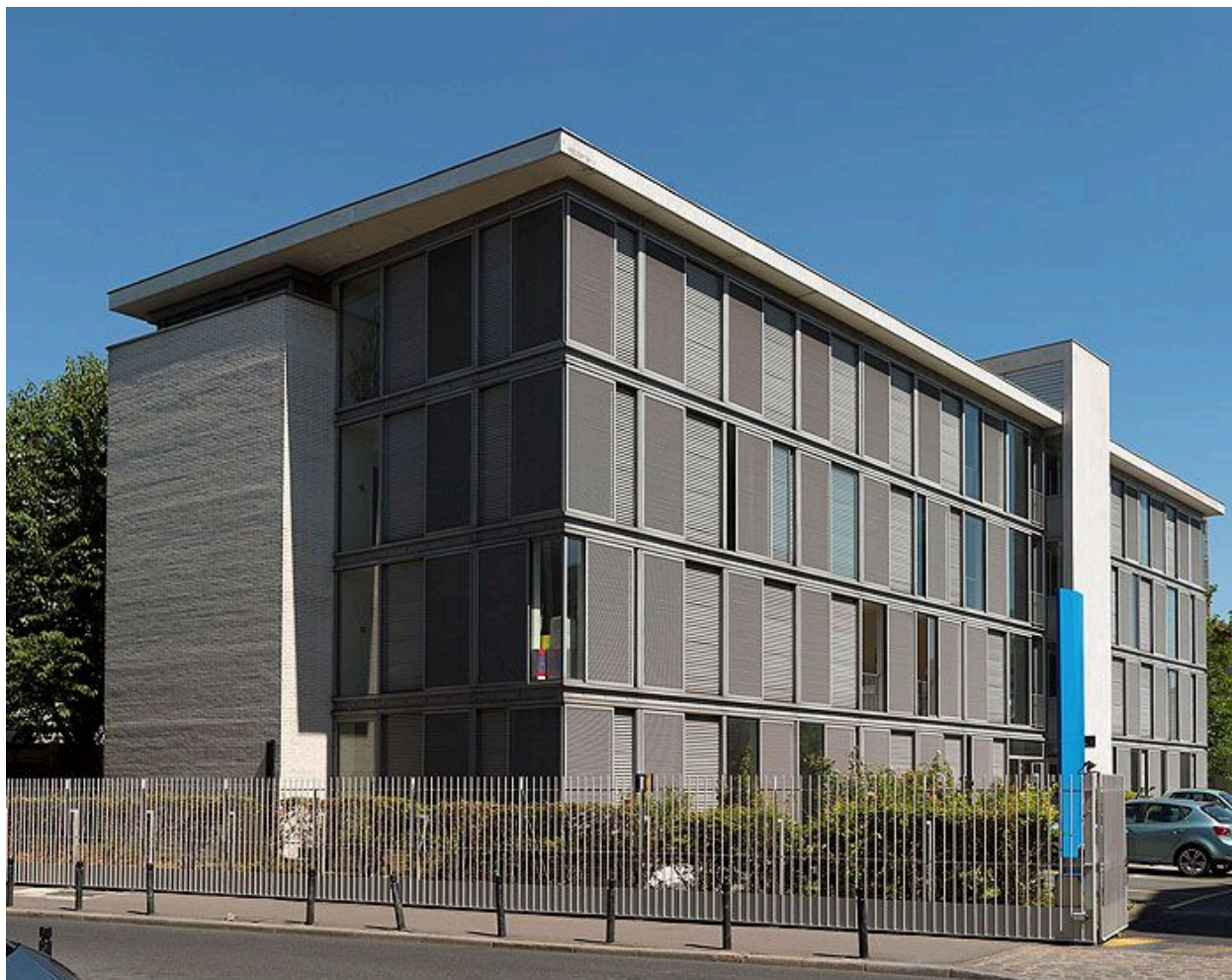
93, Aubervilliers, usine d'allumettes dite Manufacture d'allumettes, 124 rue Henri-Barbusse Vue d'ensemble des magasins de la Documentation française construits vers 2000.
