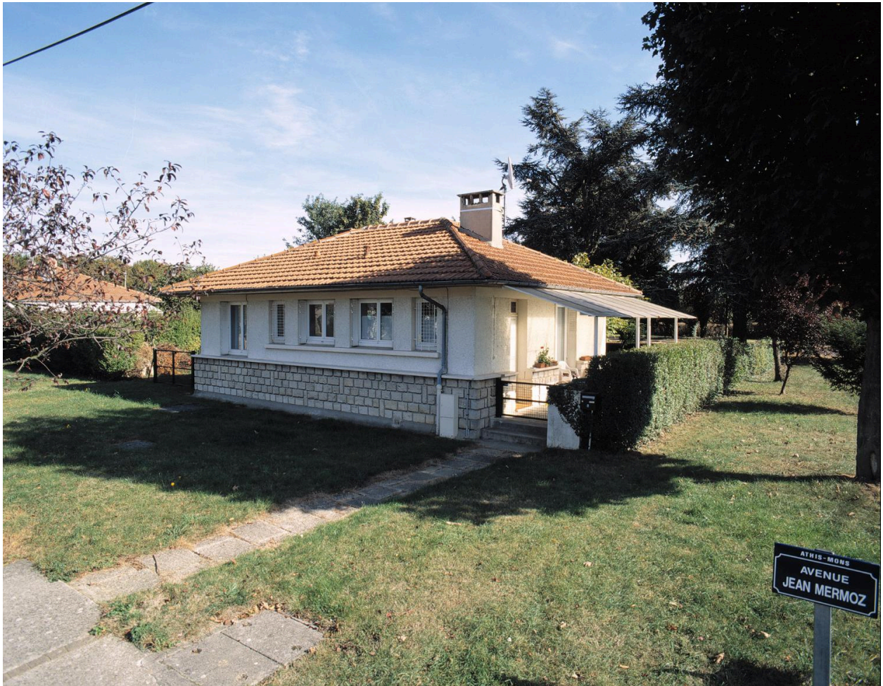
Vue d'ensemble du pavillon situé 8, avenue Jean-Mermoz.
