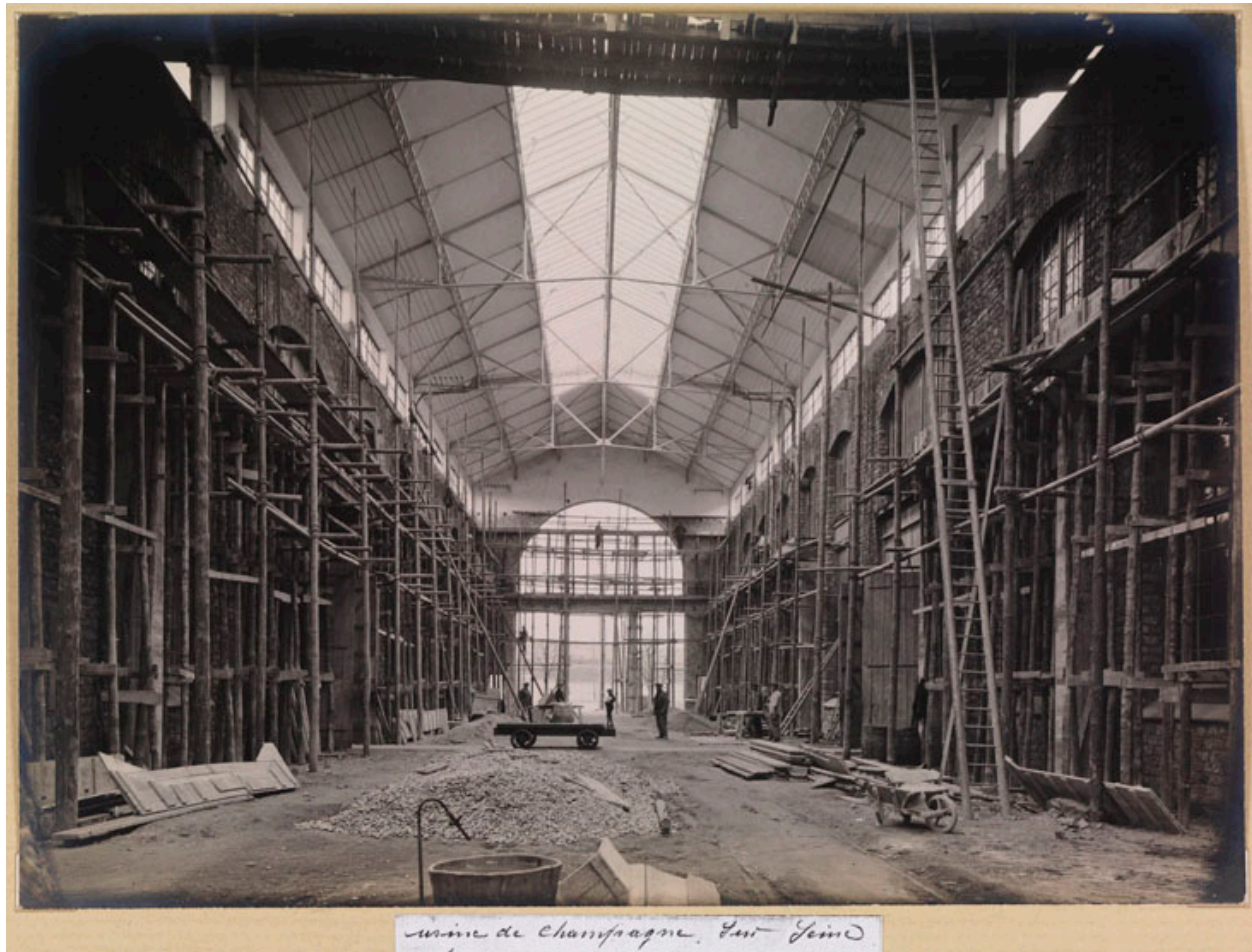
Photo ancienne, extension de l'usine. Chantier d'une liaison longitudinale.
