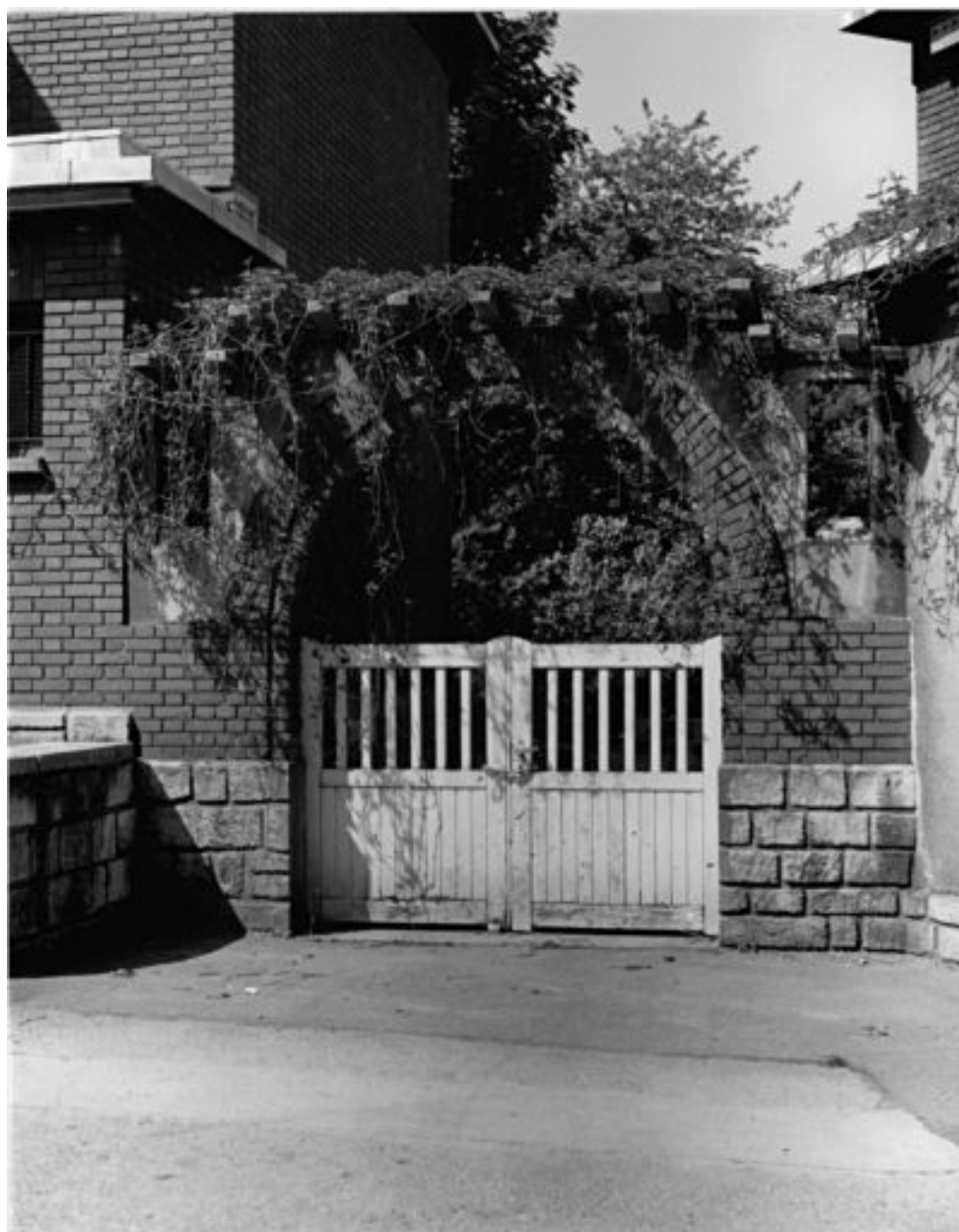
Portail cintré, rue Francis-de-Pressencé.
