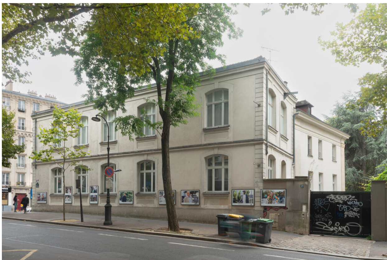
Façade postérieure sur la rue des Pyrénées. Tout à fait à droite, au second plan : la façade latérale du pavillon lui-même.
