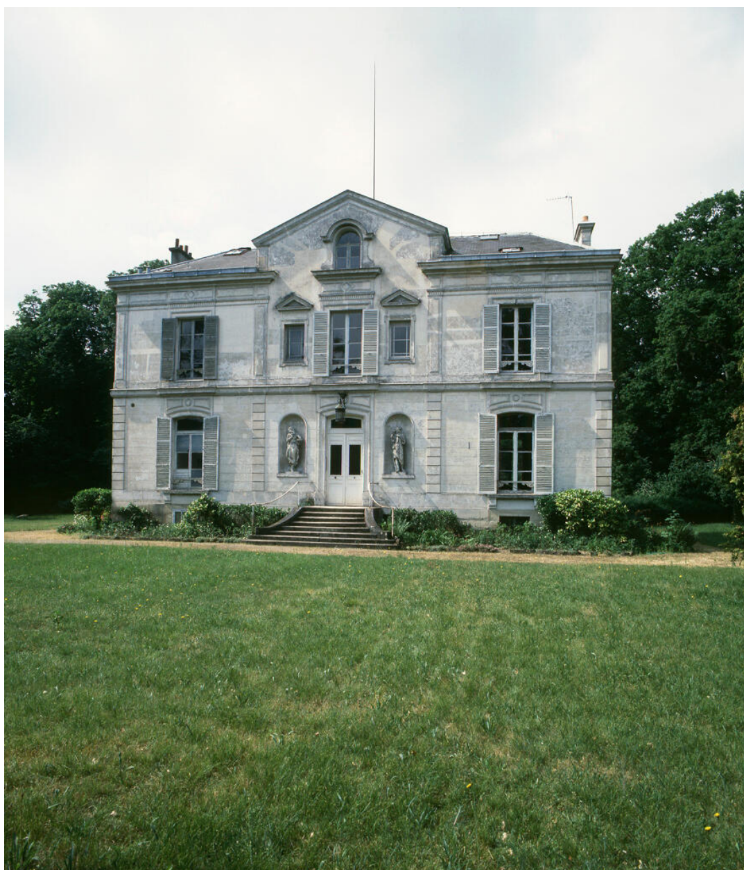
Vue d'ensemble de la façade antérieure.
