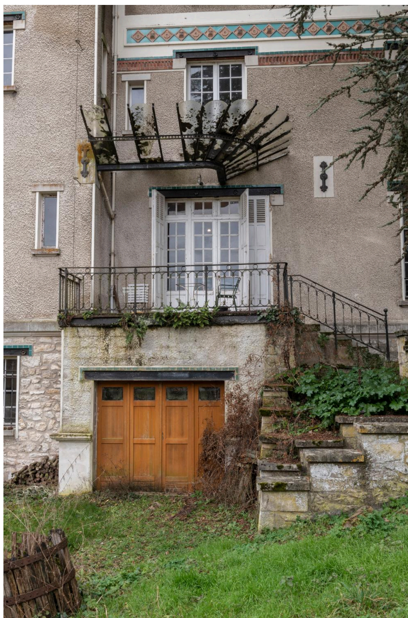
Marquise inversée de la façade nord est
