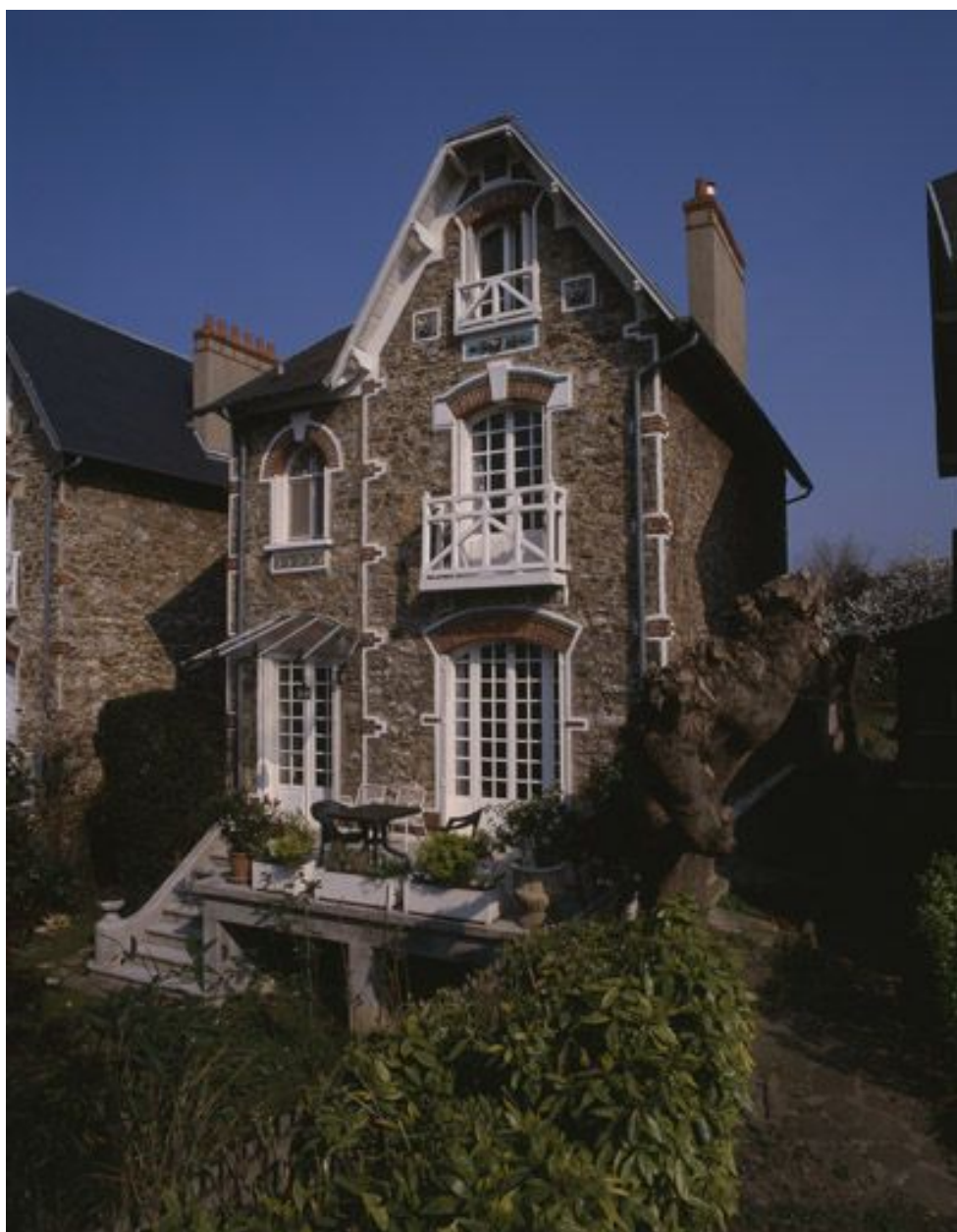
Vue d'ensemble de la maison, 57 bis avenue Libert.
