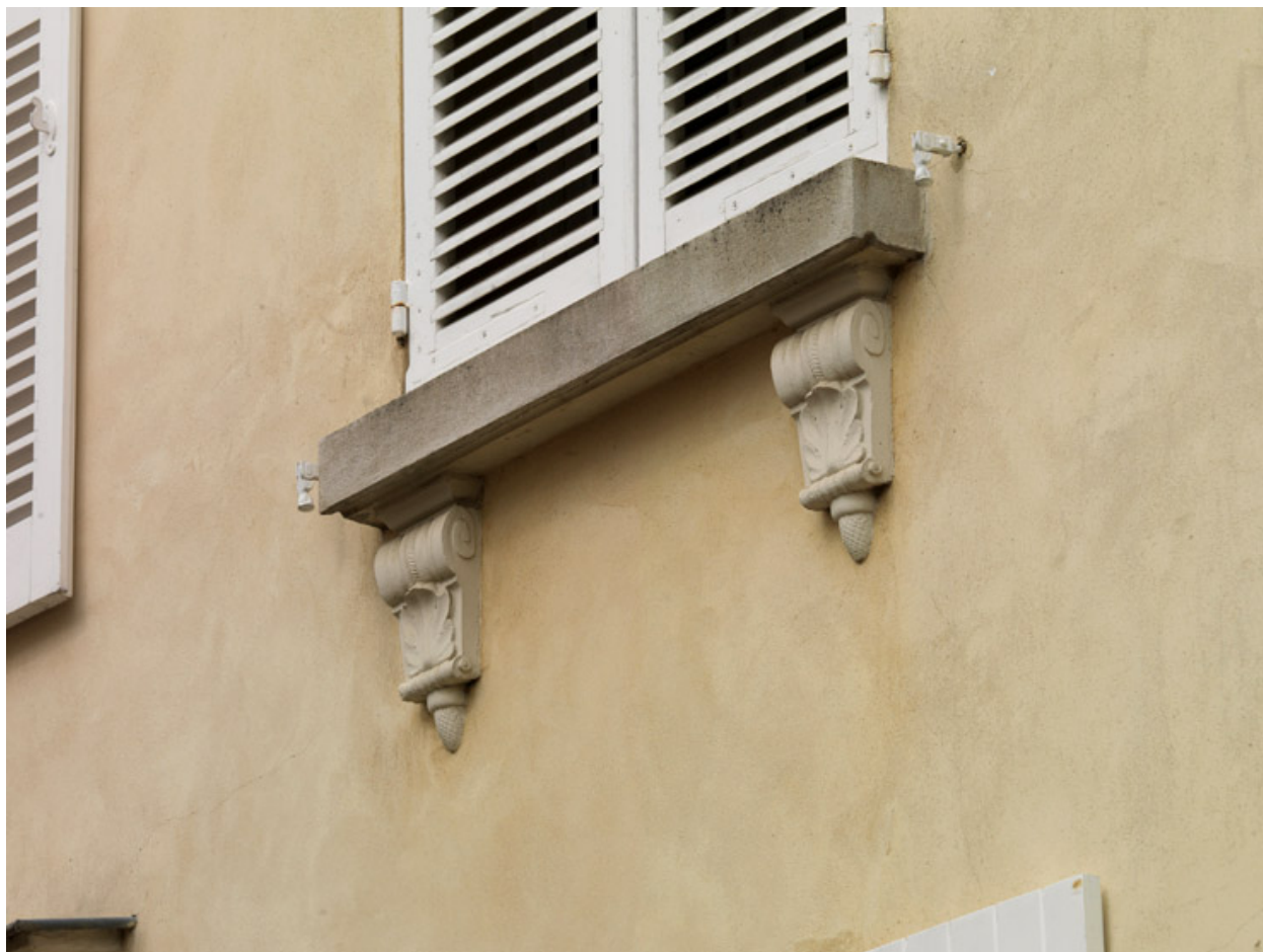
Maison de bourg, 6 rue Gâte-Vigne. Détail du décor des consoles sous les baies.
