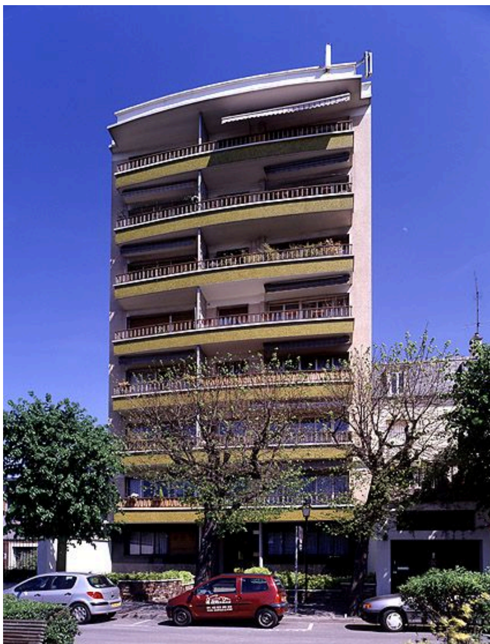
Immeuble dite résidence du bois, 4 place Pierre Sémard. Vue d'ensemble de la façade sur la place.
