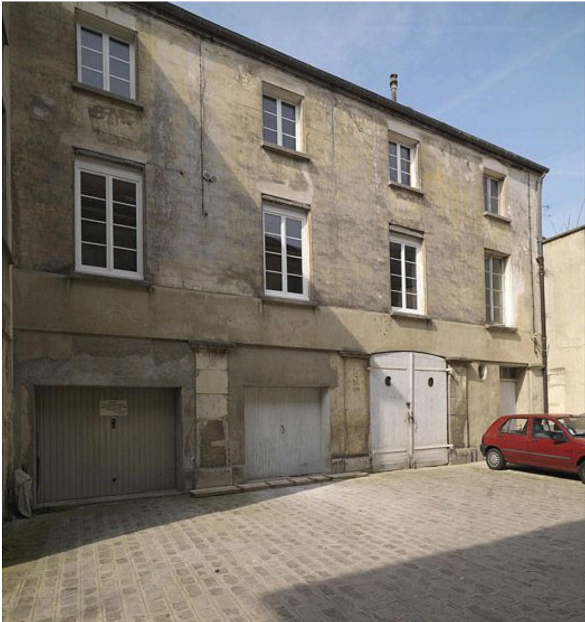
La cour à l'arrière, ouvrant au 5, rue Rochart : vue du côté ouest.
