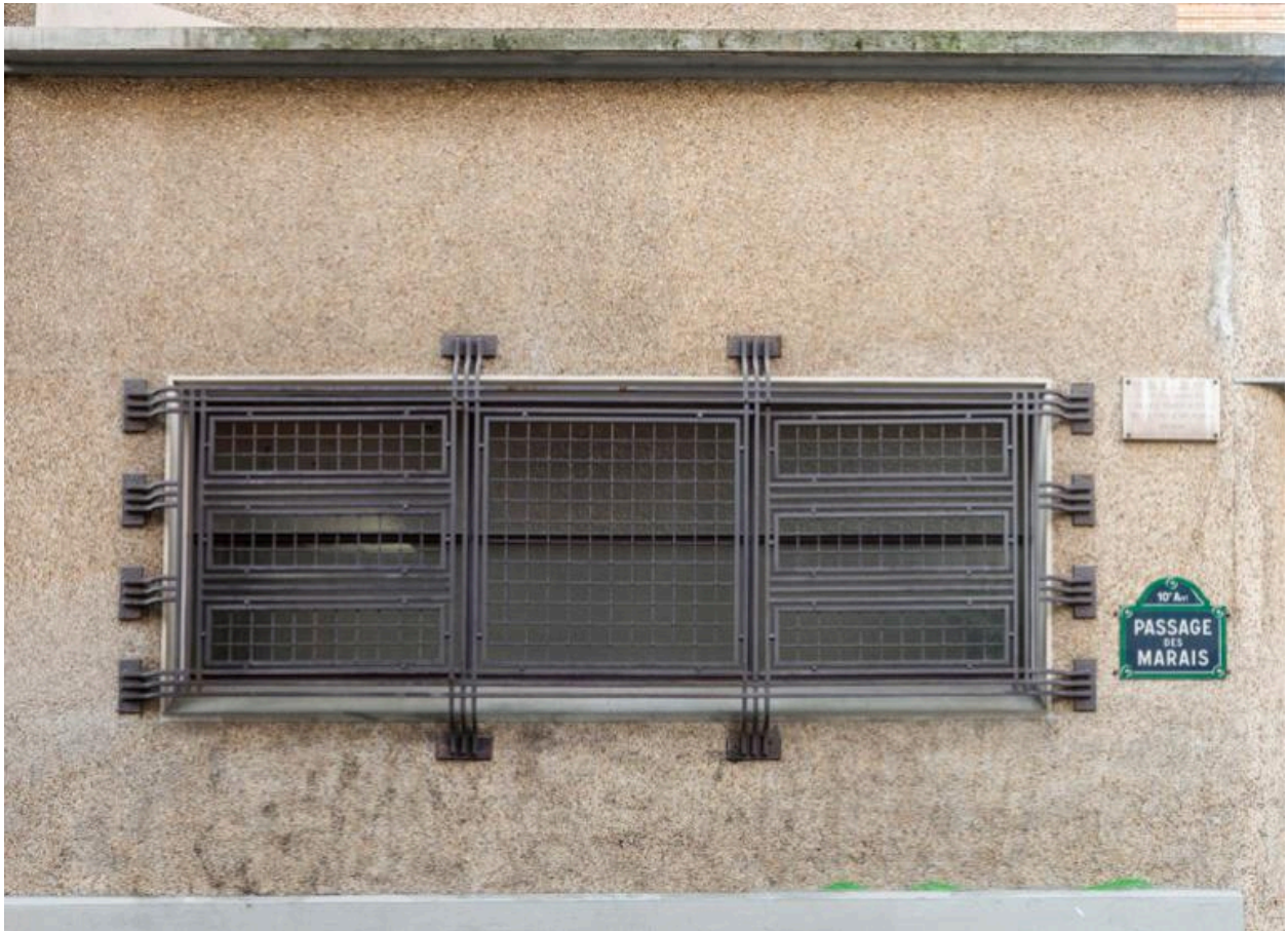
Détail de l'une des grilles en fer forgé fermant une baie, au rez-de-chaussée des bains-douches.
