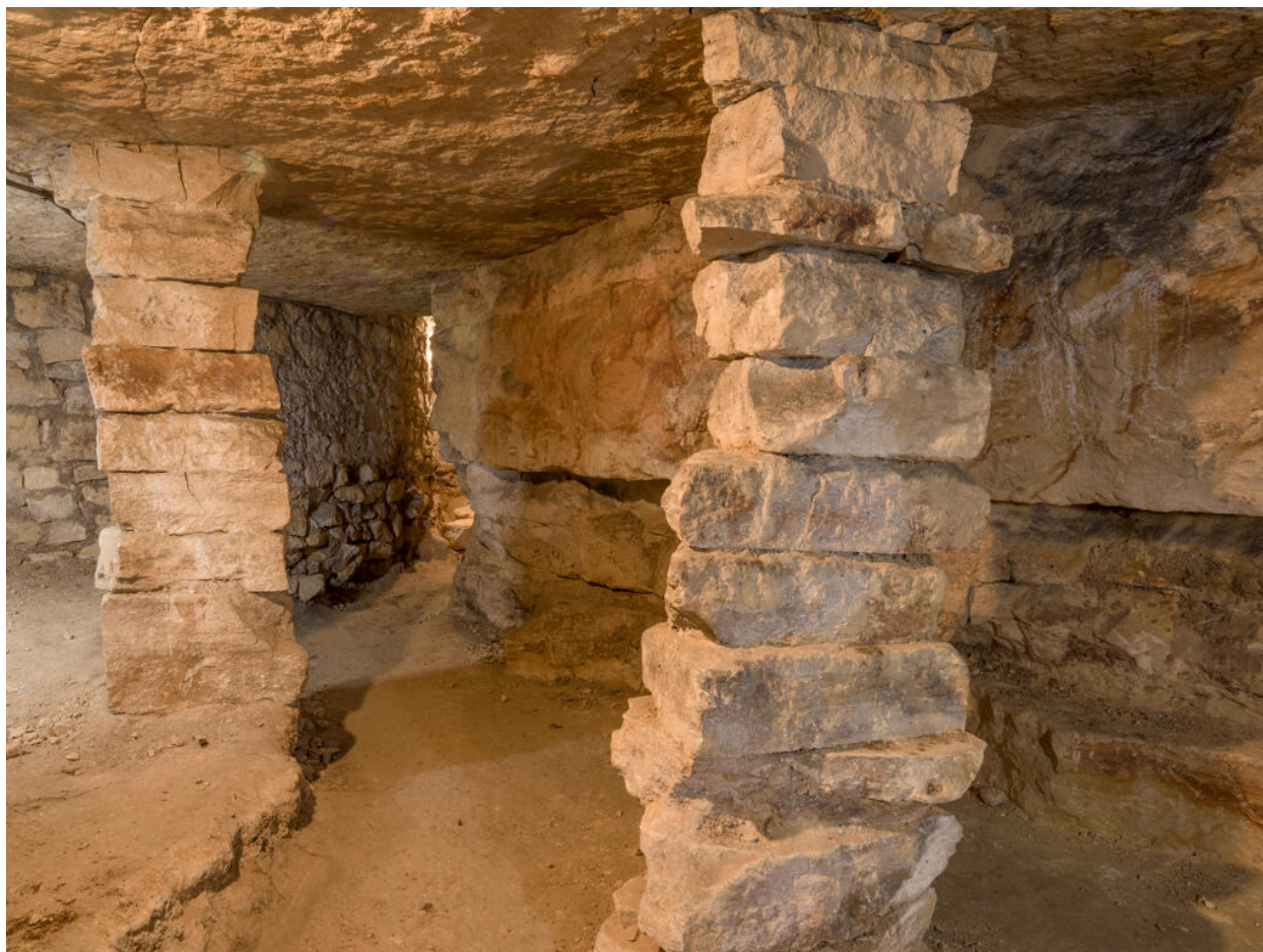
Piliers à bras et front de taille. Masse en partie souchevée.
