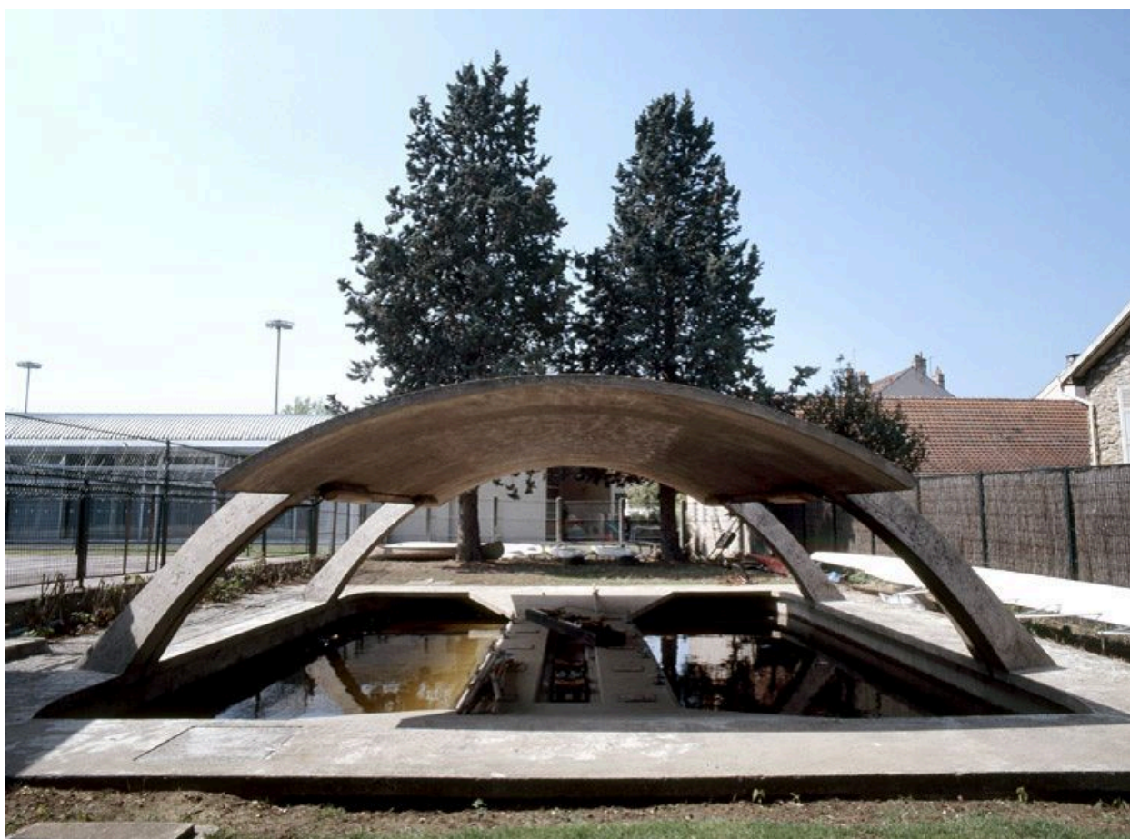
Le tank à ramer, à l'ouest de la piscine couverte : vue d'ensemble, depuis le nord.
