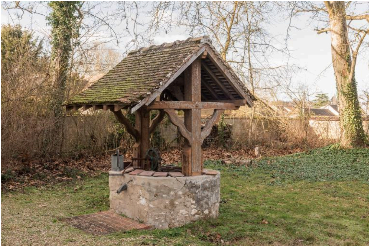
puits dans le jardin
