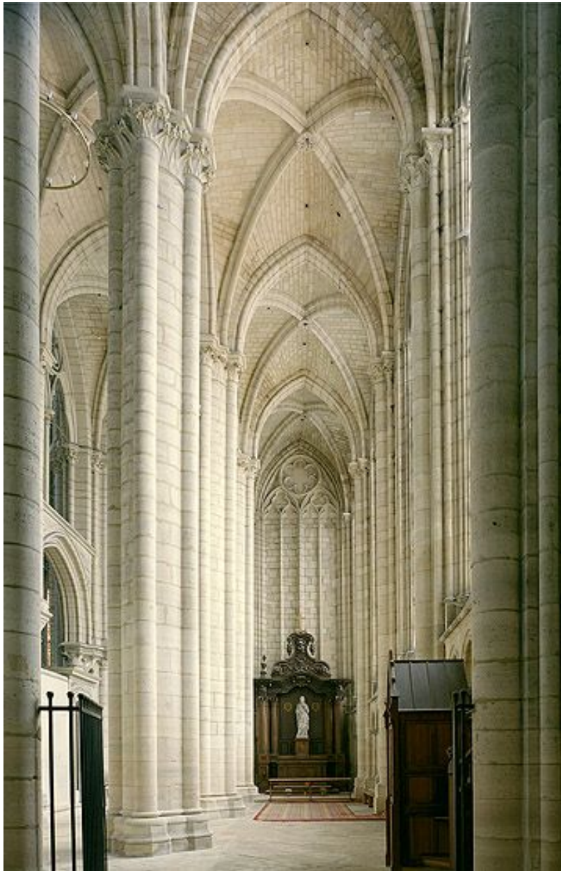
Vue des collatéraux sud du chœur, depuis le sud-ouest. Dans le fond, l'autel du Sacré-Coeur.
