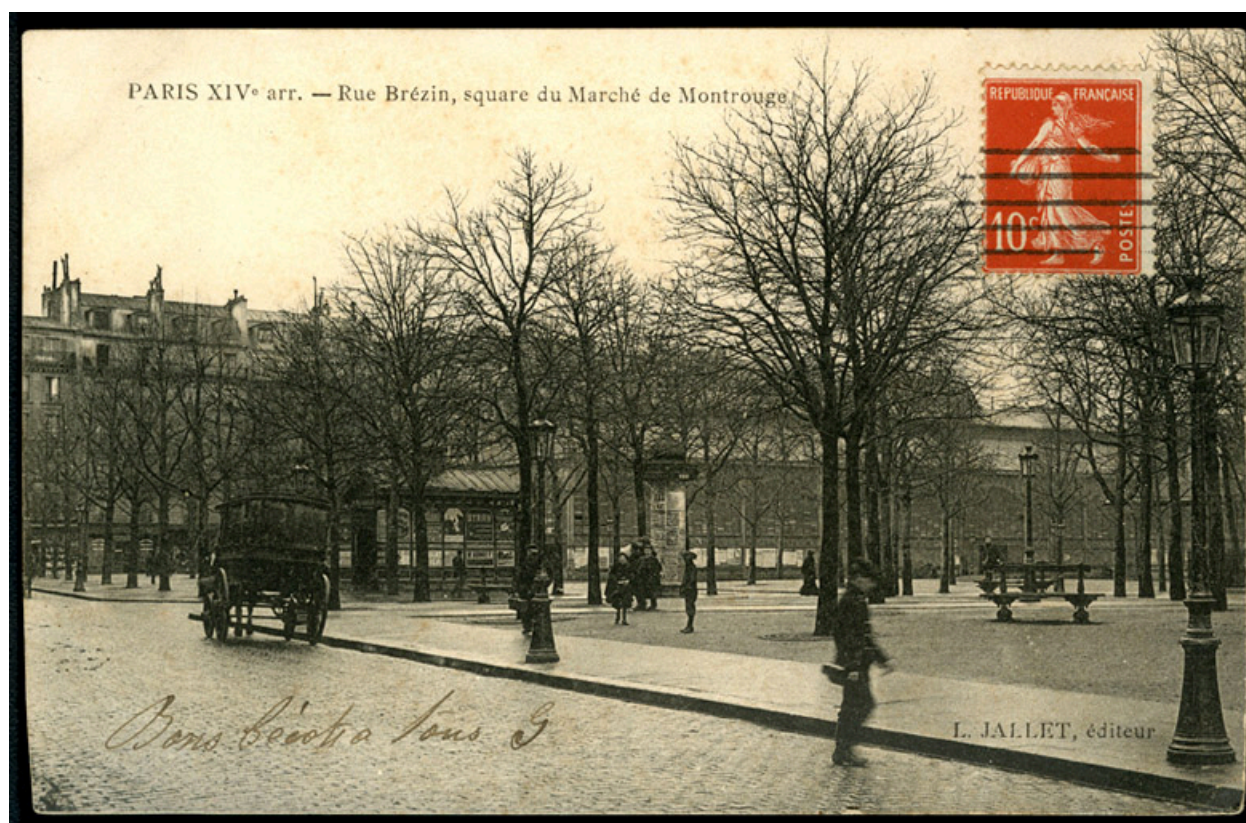
Paris XIVe arrondissement- Rue Brézin, square du Marché de Montrouge.
