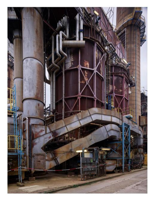
Unités Ouest - Zone de distillation (Unité 612). Fours 612 F1 A et B. Les deux gaines horizontales au premier plan sont destinées à l'alimentation en air des fours, fourni par un compresseur haut débit - basse pression. À gauche, les conduits de fumées.
