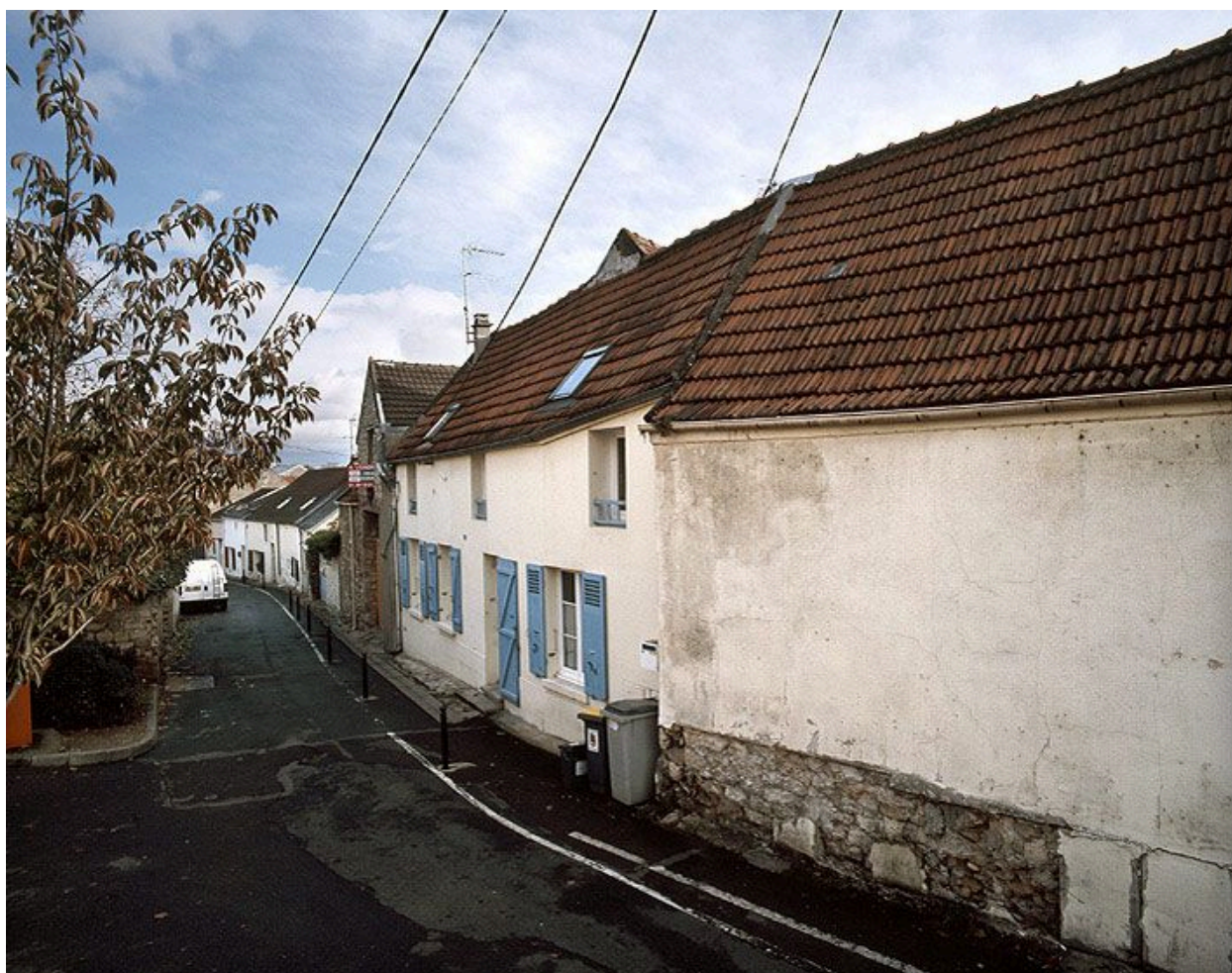
Façade arrière donnant sur la rue des Courcieux.
