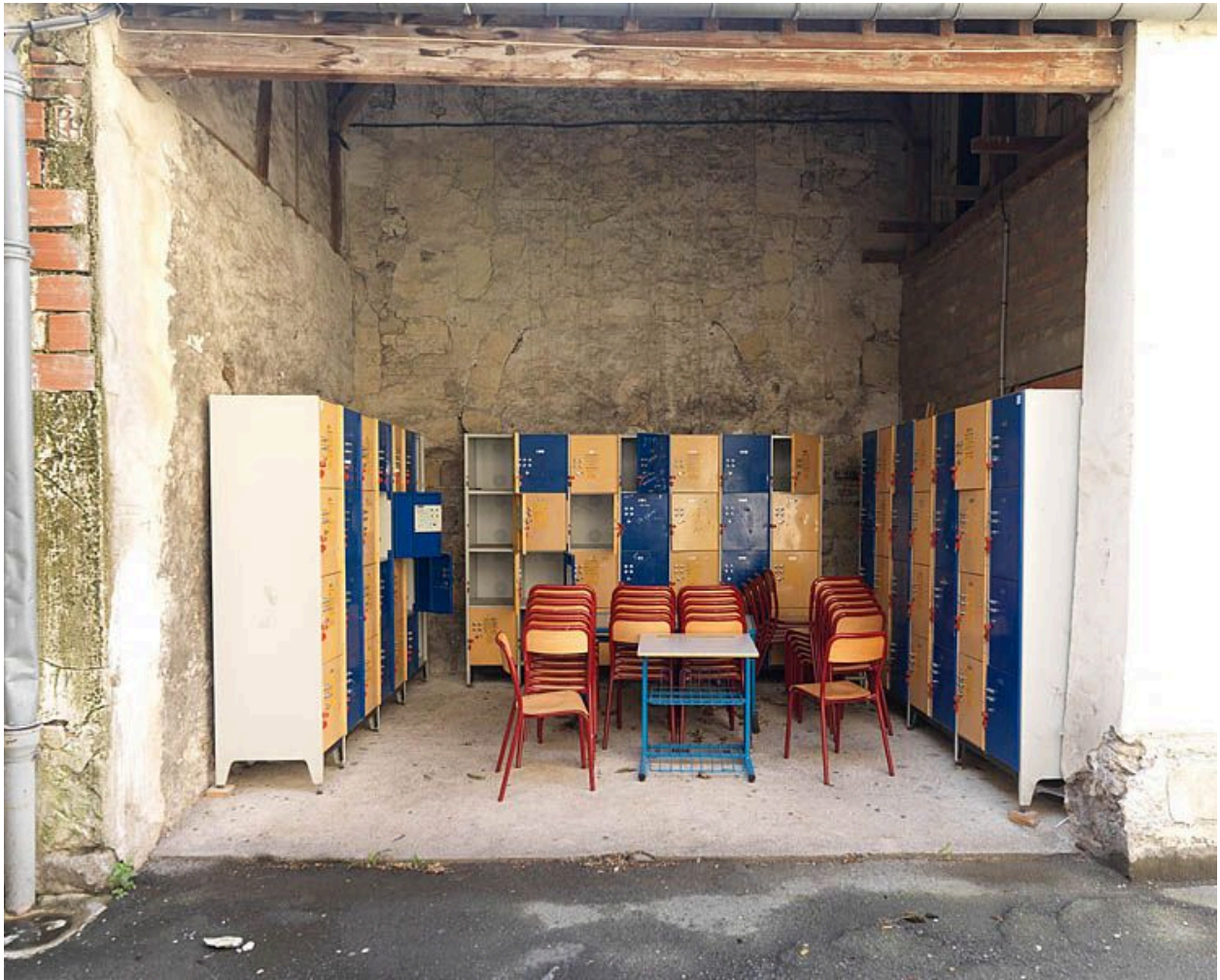
Arrière de l'ancienne chapelle du Rosaire. Vue de la mise en oeuvre. Arcades et oculi.
