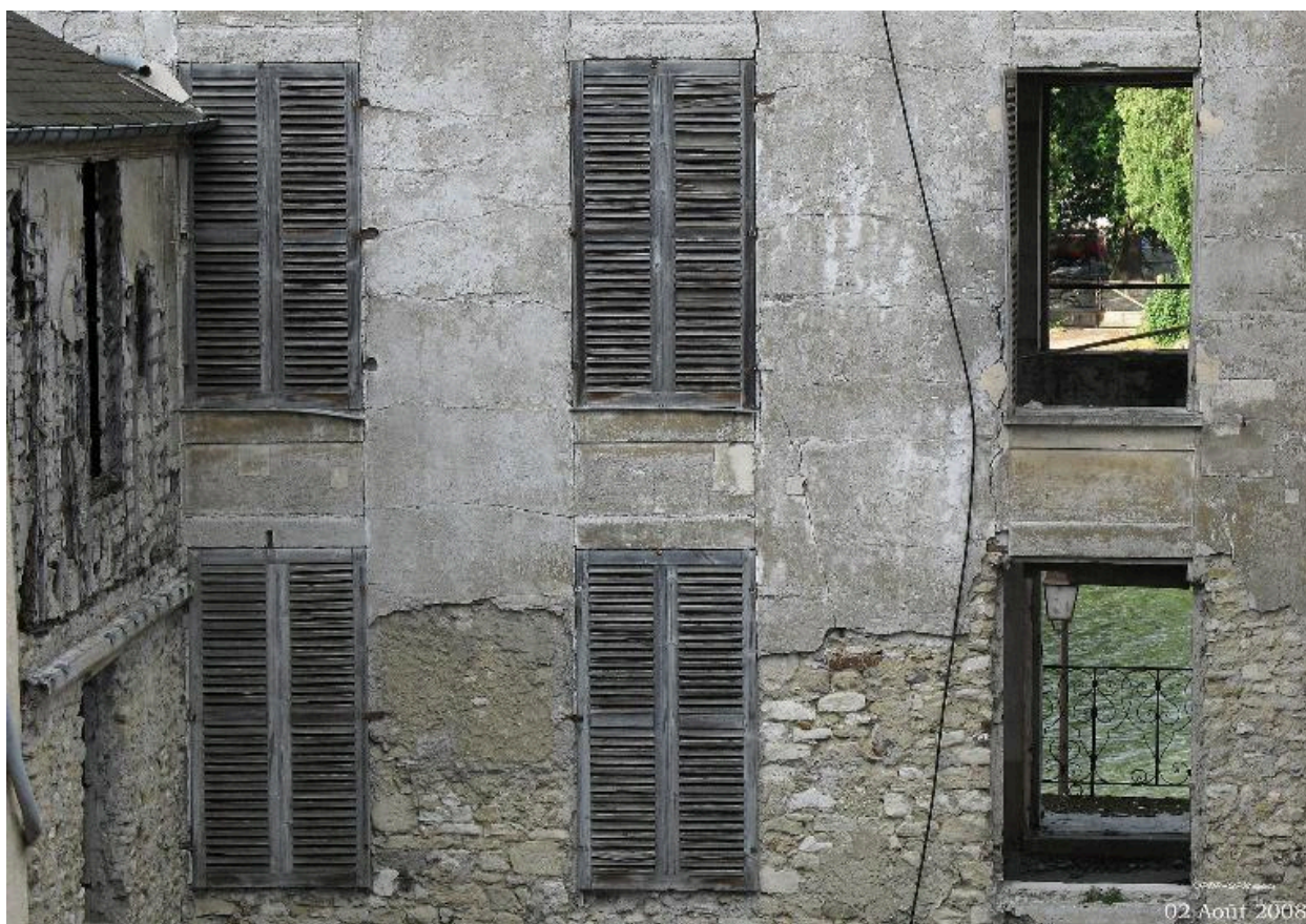
Détail de l'appareil en moellons tout venant du corps principal de l'hôtel avant restauration.
