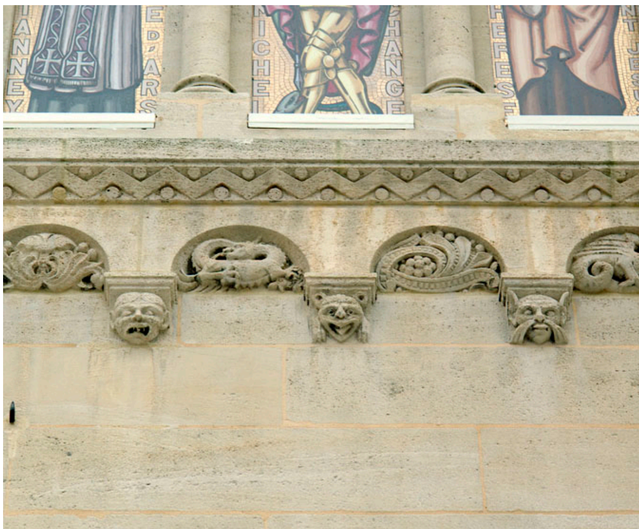
Façade occidentale : détail de la corniche.
