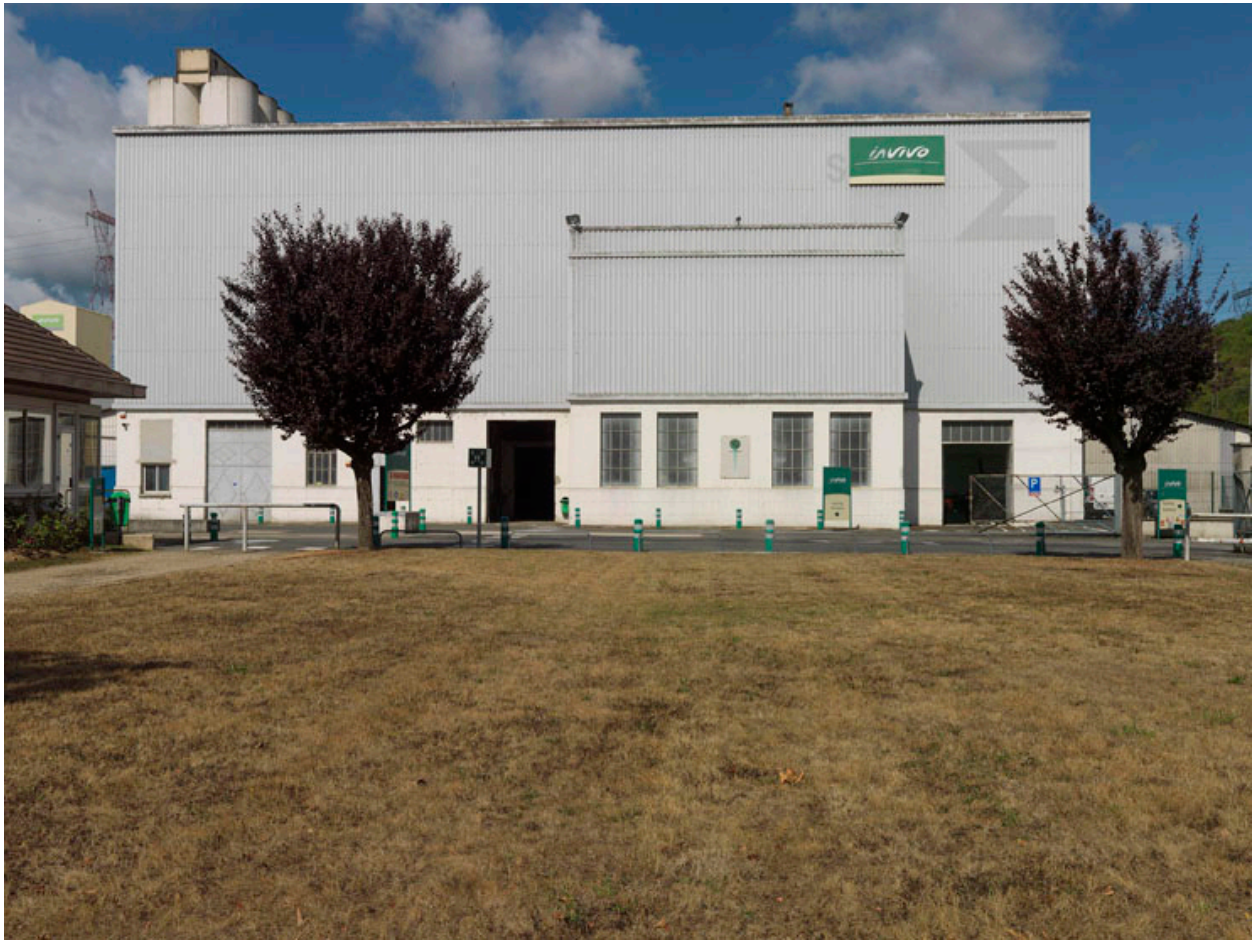
Silos de l'UNCAC de la Grande Paroisse, aujourd'hui Invivo. Vue extérieure. Bâtiment Invivo lab.
