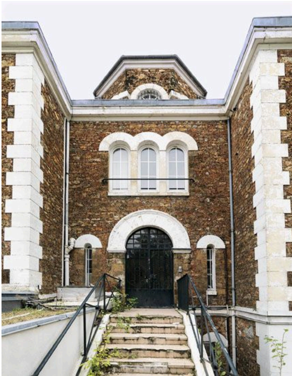
Le corps central de la façade, en vue frontale.
