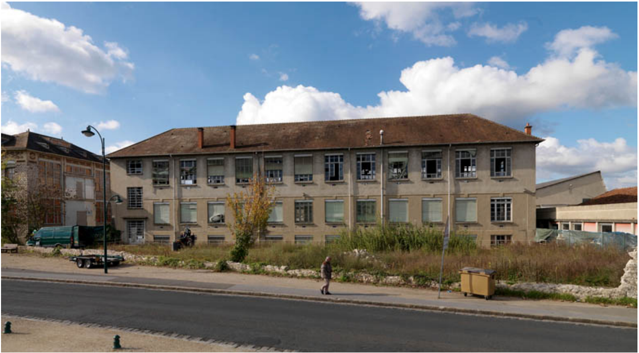
Vue extérieure. Bureaux d'études (1913-1952).
